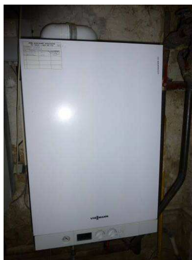
obr. 4: Plynový kotel Viessmann – zdroj tepla
