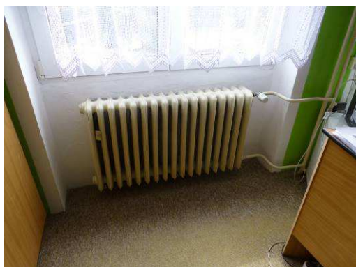
obr. 3: Otopná tělesa s termostatickými ventily
