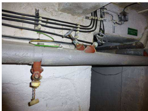
Obr. 5: Rozvody mají vyvažovací ventily
